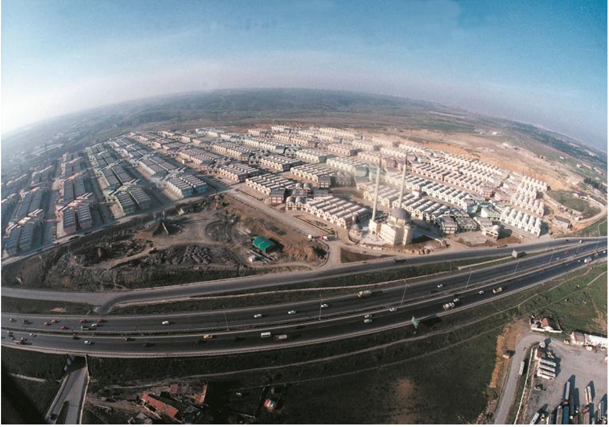
İSTOÇ TOPTANÇILAR ÇARŞI İNŞAATI (MAHMUTBEY-İSTANBUL)
