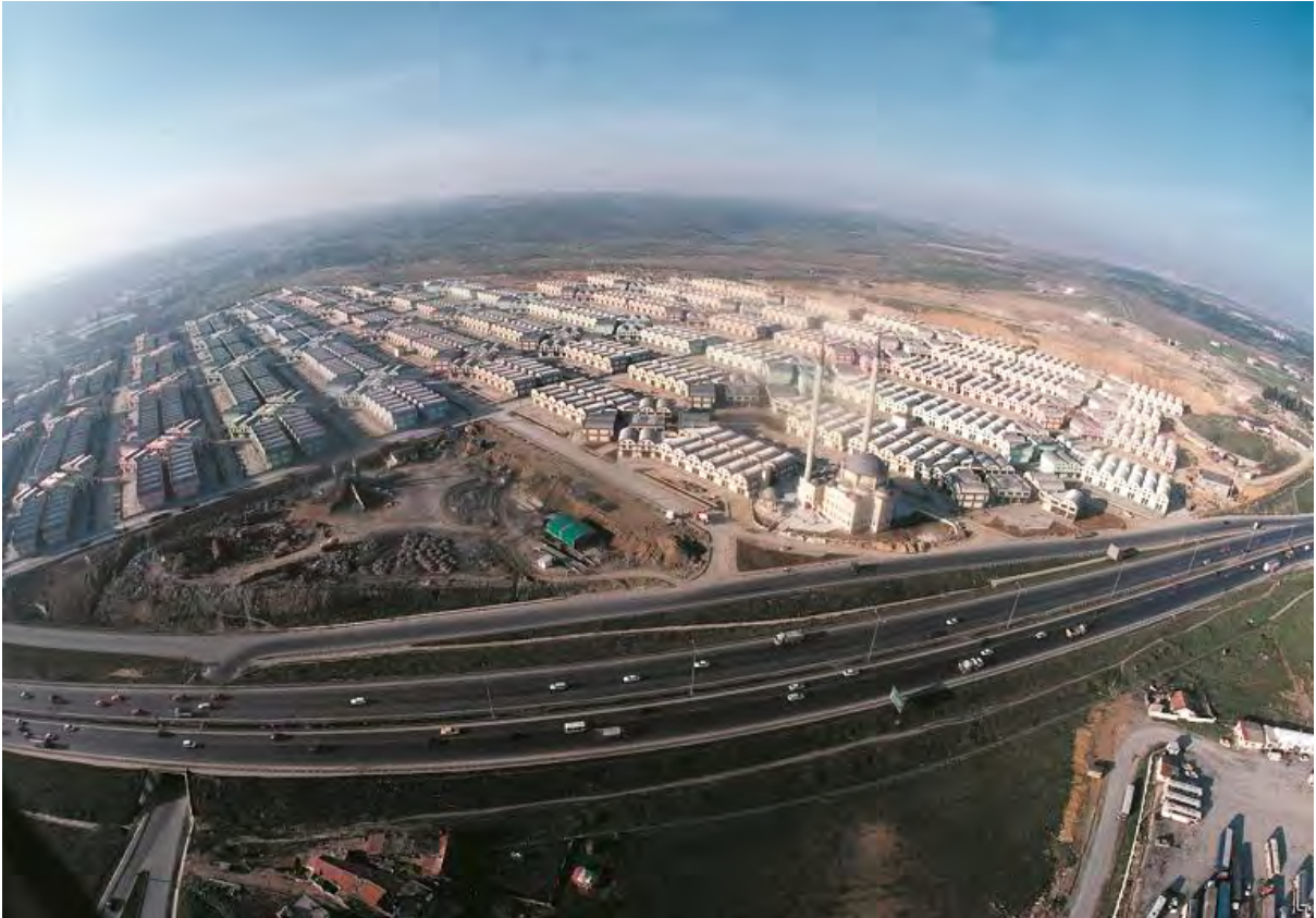
İSTOÇ TOPTANÇILAR ÇARŞI İNŞAATI (MAHMUTBEY-İSTANBUL)
